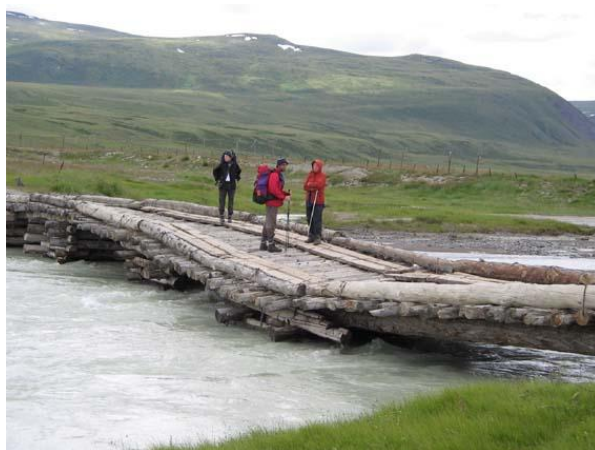
Фото 23. Мост через Ак-Аллаху в Бертеке днем +12-15С, переменная облачность.
