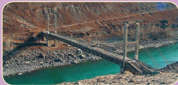
средний речной пролет равен 100 м. Пилоны моста высотой 21 м представляют собой качающиеся железобетонные рамы. Цепи моста перекинута через вершины пилонов и закреплены в анкерных плитах. Весь мост производит впечатление изящного и легкого. Мост эксплуатировался до 1970 г., до того времени, когда рядом был введен в строй новый железобетонный мост через Катунь. В 1994 г. мост объявлен памятником истории и культуры Российской Федерации.
